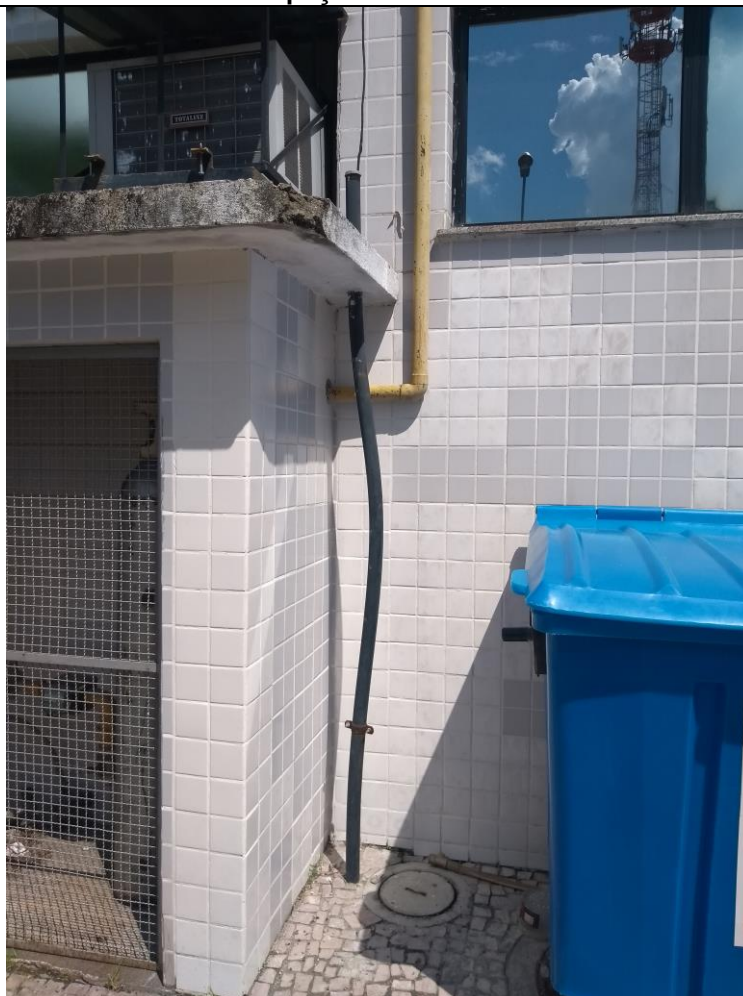
9 – SPDA passando perto de tubulação de gases
