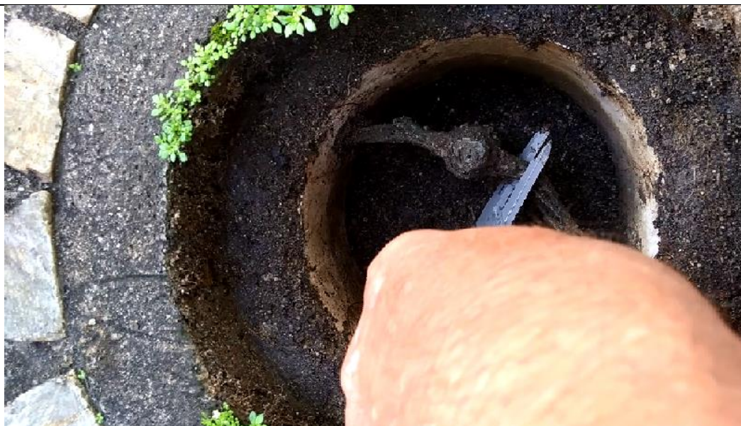
8 – Caixa de inspeção de SPDA e Aterramento
